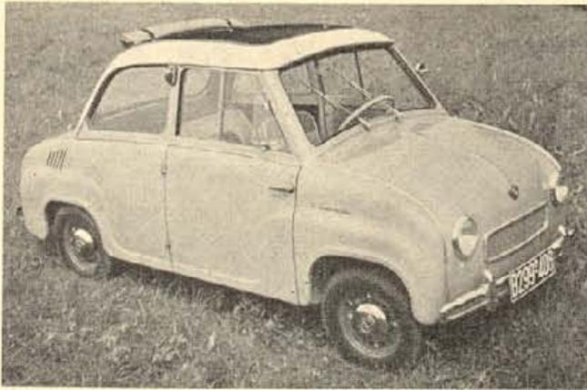
Die Rolldachmechanik ist denkbar einfach und schnell zu betätigen. Bei stärkstem Dauerregen erfolgt an keiner einzigen Stelle ein „Wassereinbruch“. Der Beifahrersitz zum hinteren Einstieg ist mit Lehne und Sitz umklappbar
